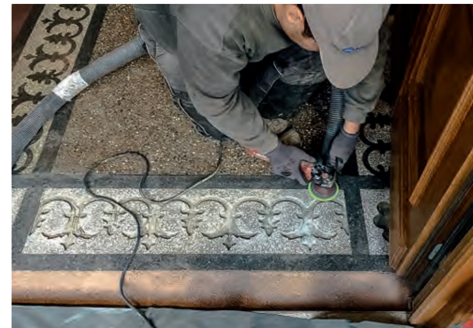
Arbeitsschritte bei der Erneuerung eines Ceconi-Terrazzos © Hlawna GmbH
