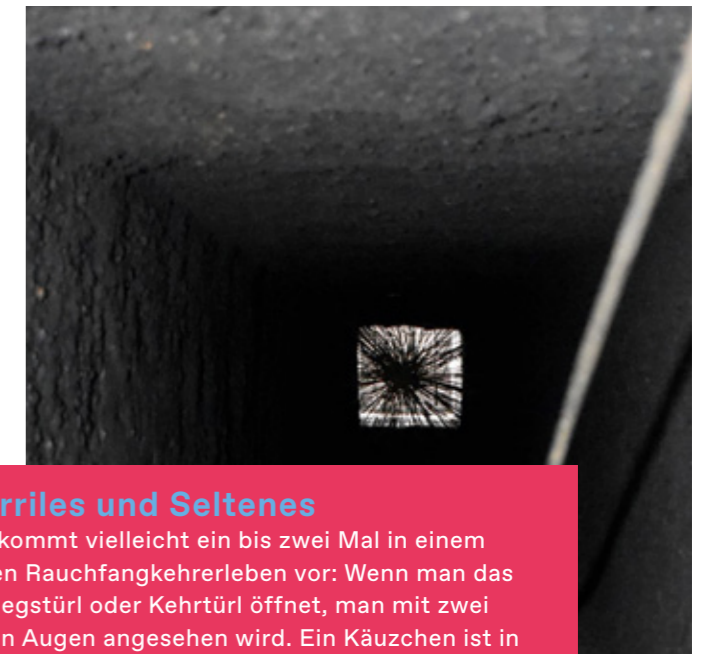
Reinigen mit der Schlieferbürste im Rauchfang © Andrea Frais
